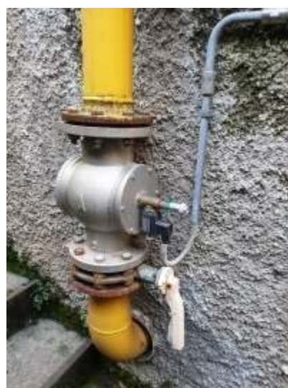
Leva chiusura gas centrale termica
